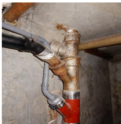
Faldstamme i kælder
